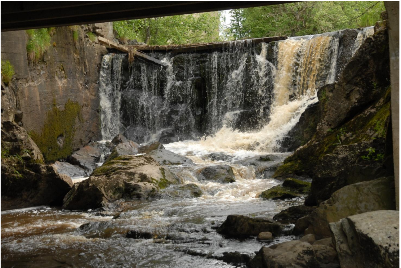
Kuva 8. Hirvijoen Pyykosken pato.
