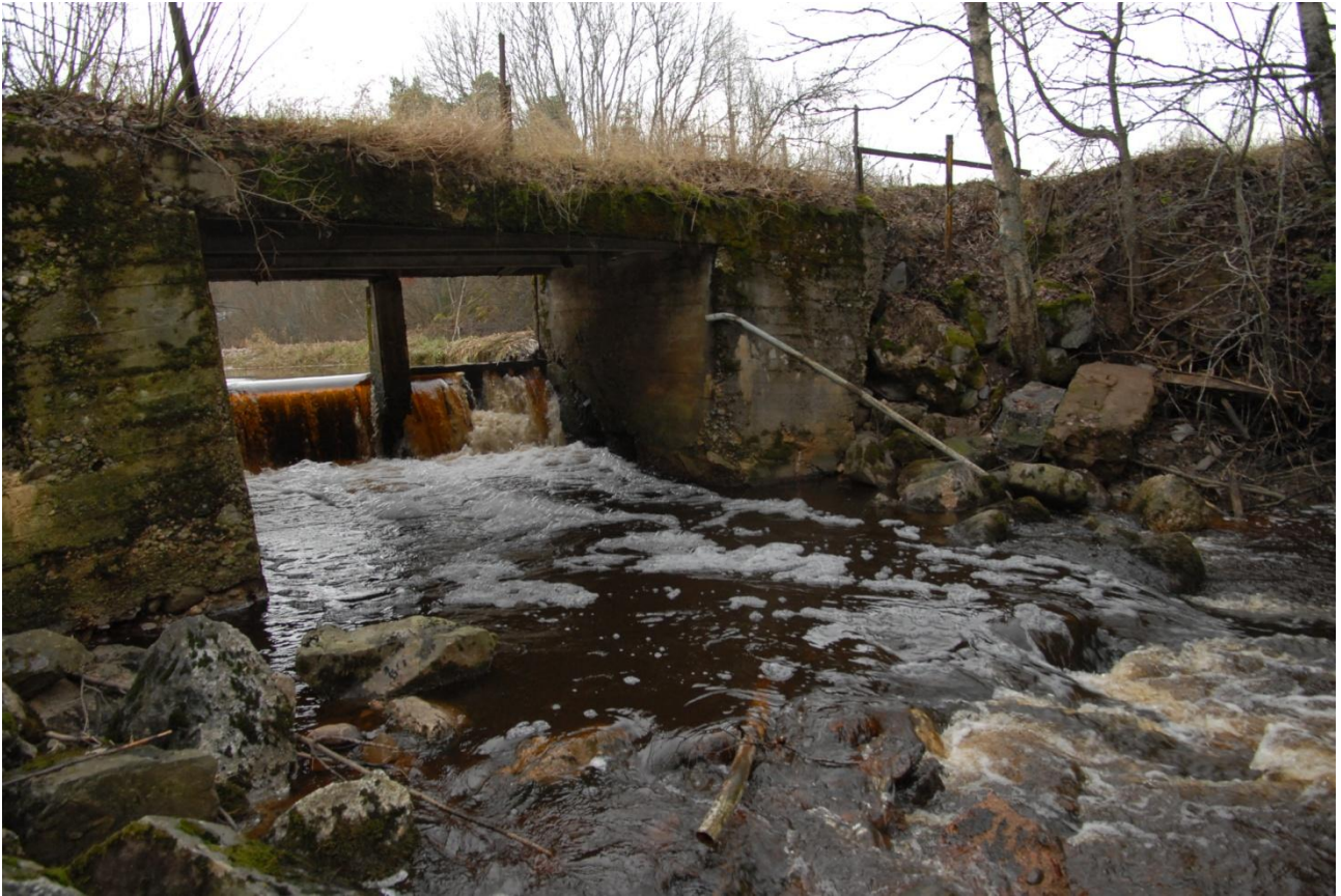
Kuva 9. Valpperin sahan pato.
