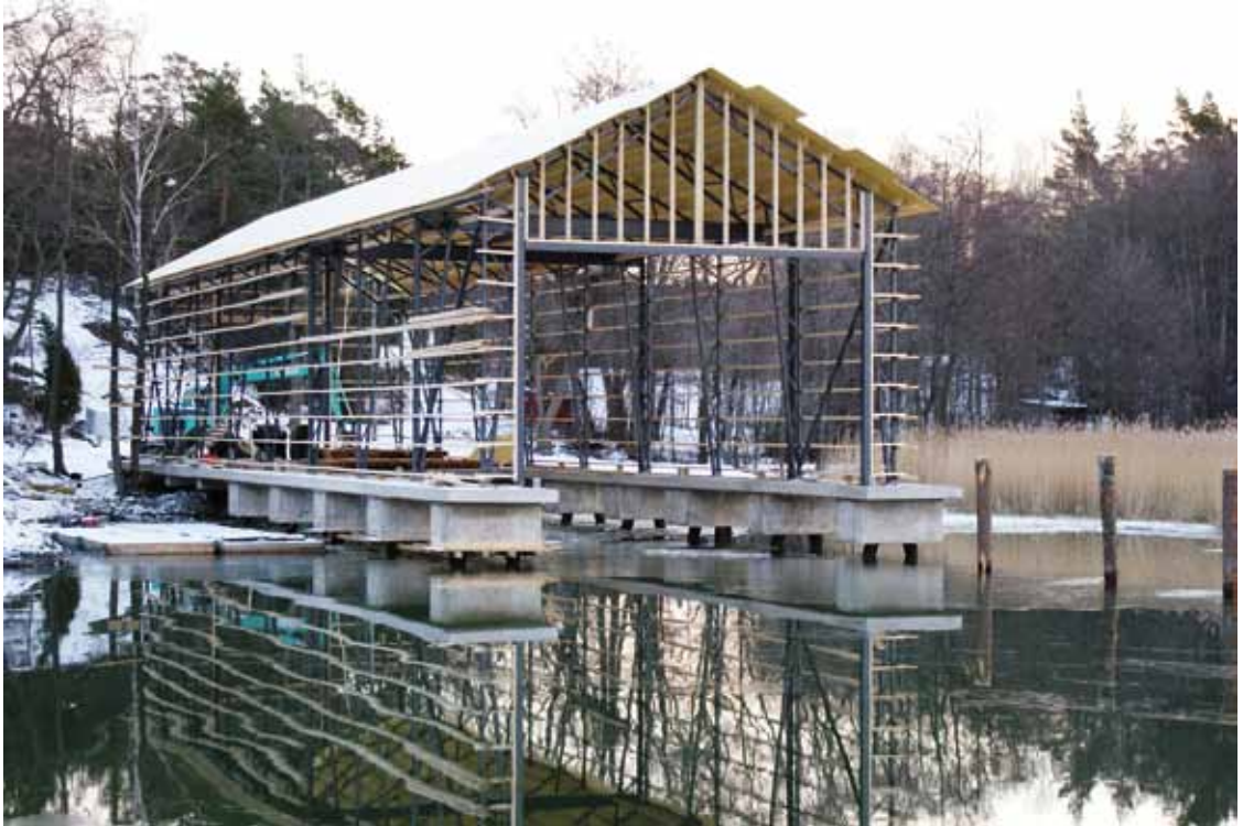
Seilin uusi venehalli rakennusvaiheessa tammikuulla 2009. Lautaverhoiluun saava teräsrunko lepää betonisokkelilla, jotka on perustettu symmetrisen viistopaalutuksen varaan. Koneellinen paalutus ja betonivalettujen perustusten käyttöönotto edustavat rantavajojen elinkaarta pidentäviä uudistuksia muuten vahvasti perinteisiin sitoutuvassa vajarakentamisen traditiossa. Kuva: Keijo Alastalo 2009
