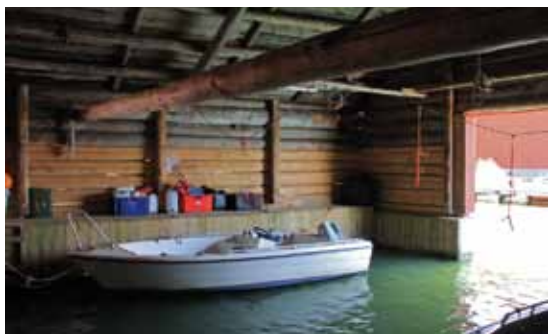
Peruskorjauksessa vuosina 2004–2005 venevajan alempia hirsikertoja vaihdettiin uusiin ja perustukset ja kulkusillat uusittiin kokonaan. Vaja on jälleen uuden veroinen. Kuva: Totti Tuhkanen 2011
